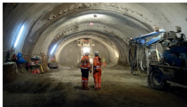
Tunnelbau mit Sprengvortrieb Bilder: BeMo Tunnelling GmbH, Innsbruck
