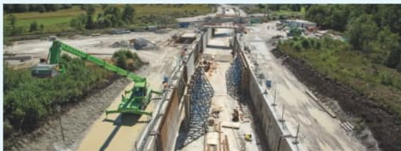
Bauarbeiten im Projekt B 23 Ortsumgehung Saulgrub Foto: BSE-AIRpix, Schongau
