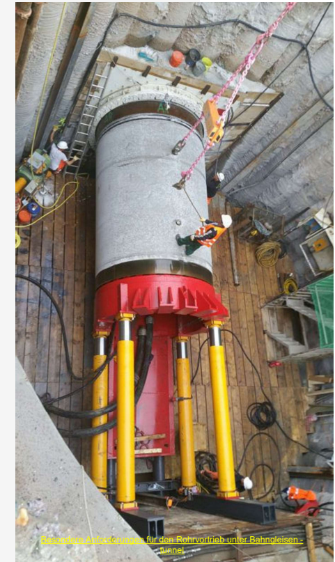
Rohrvortrieb
