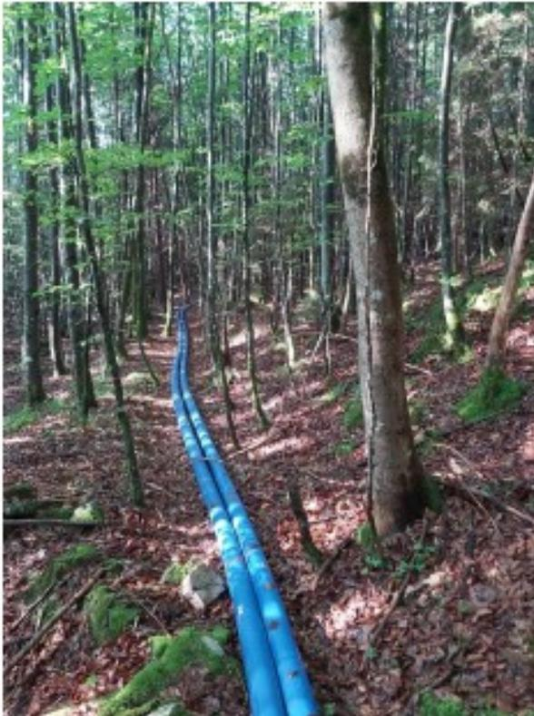
Abb. 21: Beispielfoto für eine „fliegende“ Leitung, Quelle: Staatliches Bauamt.
