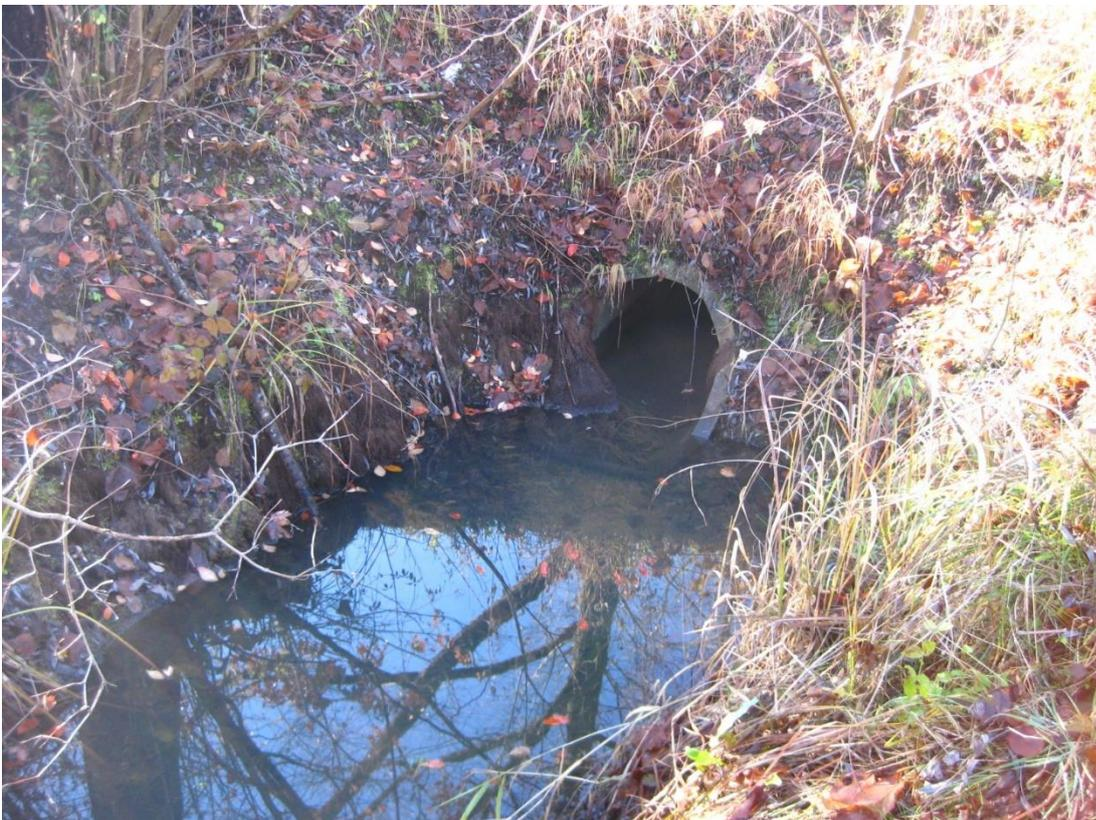
Bild 10: Zuläufe von Straßenabläufen der B2: 2x DN 200 B
