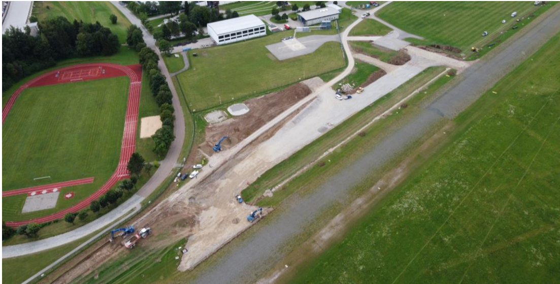
Infrastrukturelle Anpassungen am Sprunggelände Altenstadt / Heeresflugplatz Altenstadt
