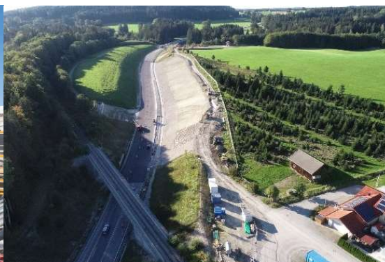
Böschungssanierung an der B472 - Umfahrung Hohenpeißenberg (2000)
